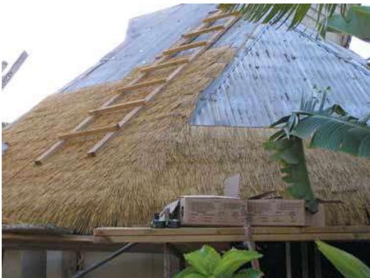
Exemple de pose de tuiles en makuti synthétique sur toiture avec pare-pluie.
